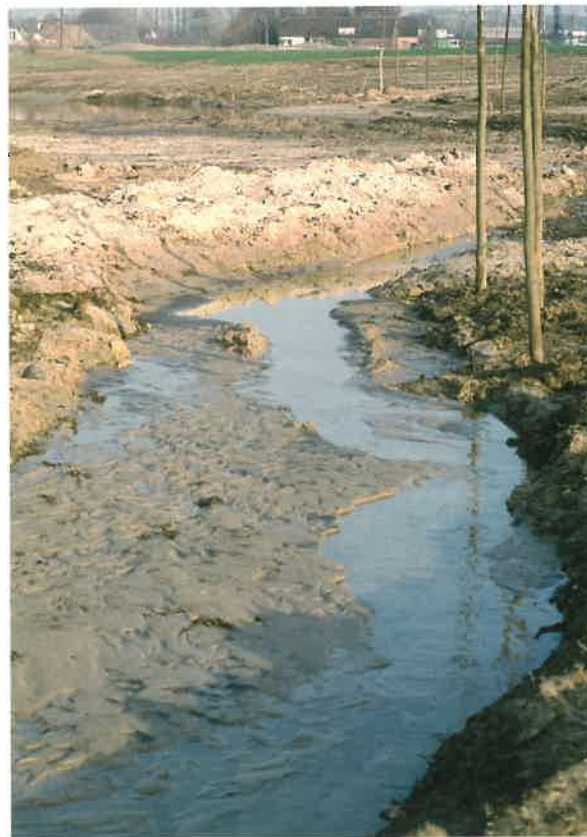
IV-12: Hier wird die obige Fließrinne durch einen Mäandrierbau ökologisch aufgewertet.
